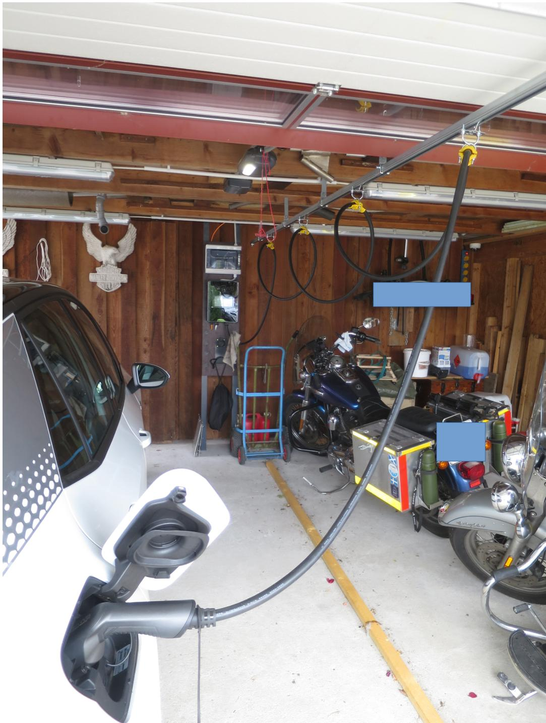
Meine Lösung zum “Schleppkabel” über den Betonboden. Schiene + Schleppwagen gibts bei jedoch nicht nur da.
